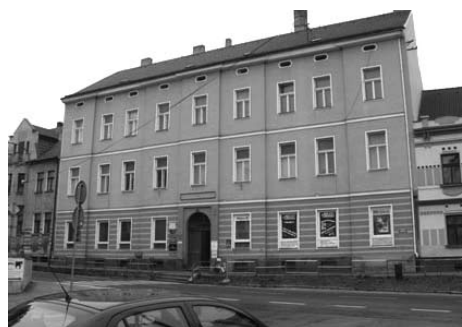
Budova, ve které sídlí pobočka Arkády – sociálně psychologického centra, o. s. v Milevsku
