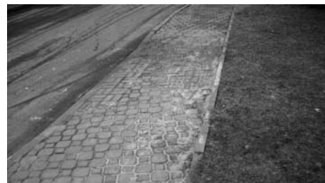
Místo vhodné pro přecházení – na rozdíl od přechodu pro chodce zde není svíslá dopravní značka, ani zebra na vozovce.
