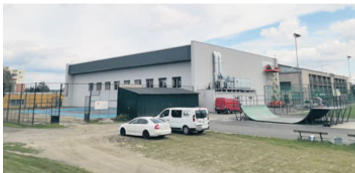
Rekonstruovaná sportovní hala
