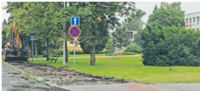
Opravený chodník před II. ZŠ
