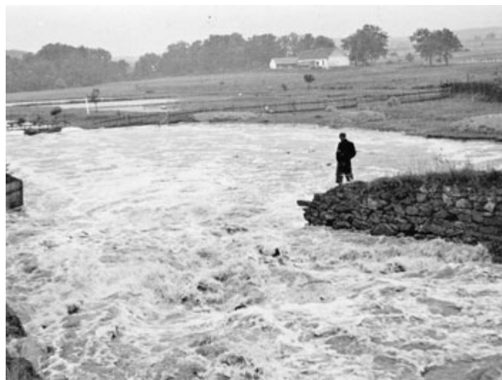
Zatopená novostavba koupaliště Na Sádkách, směrem od hráze Korunského rybníka, květen 1940. (Milevské muzeum)
