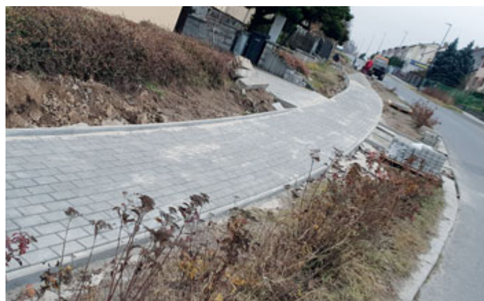
V ulici Blechova začala rekonstrukce chodníku.
