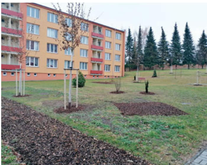
Od 8. listopadu probíhají v ul. J. A. Komenského dokončovací práce revitalizace sídelní zeleně. V lokalitě se uskutečňují intenzivní výsadbové práce navržených stromů a soliterních keřů.
