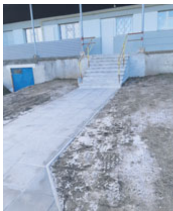
Schodiště na stadioně v novém.
