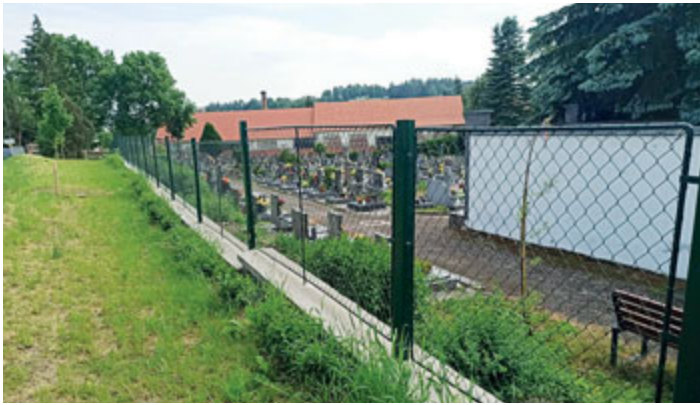
Rekonstrukce plotu na milevském hřbitově je hotová.
