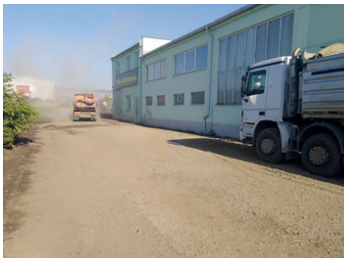
Oprava zpevněných ploch ve Veselíčku.
