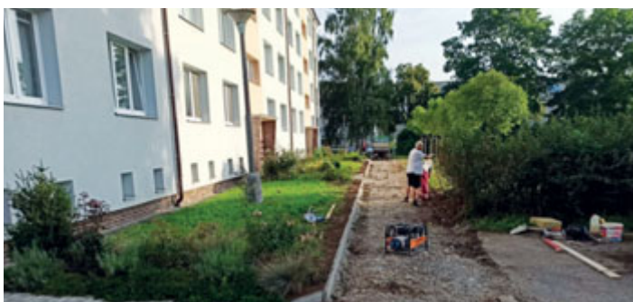
V úterý 10. srpna začala rekonstrukce chodníku před bytovým domem v Komenského ulici vedle Vzoru.
