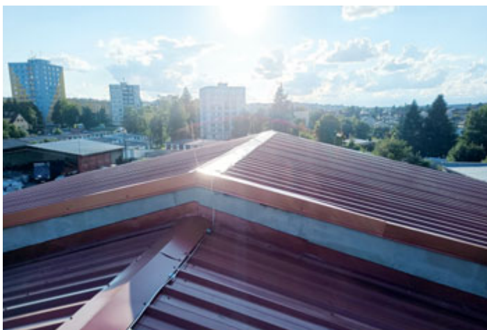
Po červnové bouři má budova Služeb Města Milevska opět novou střechu.
