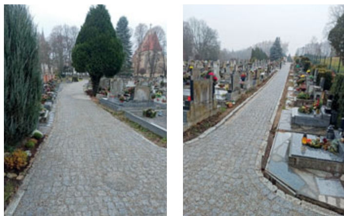
První etapa rekonstrukce chodníků na milevském hřbitově je zdárně u konce.
