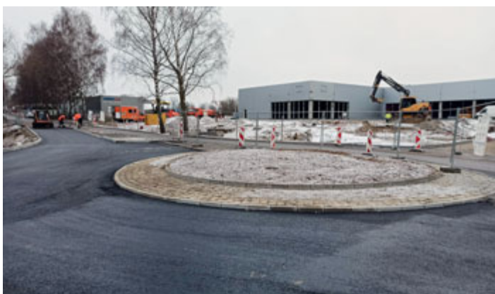
I přes nepřízeň počasí práce na výstavbě okružní křižovatky v Blanické ulici běžely podle plánu.
