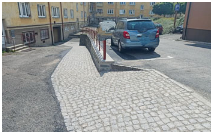
Rekonstrukce chodníku v Souhrádkách je hotová.
