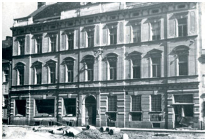
Pohled na budovu Okresní hospodářské záložny na milevském náměstí. Snímek byl zhotoven v květnu 1950, krátce po atentátu, což dokládají vyražená okna vlevo od vchodových dveří. Foto ze sbírek Milevského muzea.
