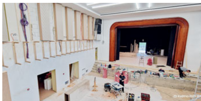
Práce na rekonstrukci velkého sálu domu kultury probíhaly v průběhu května především na akustickém řešení celého prostoru.
