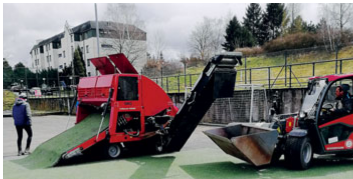
Výměna umělého trávníku.
